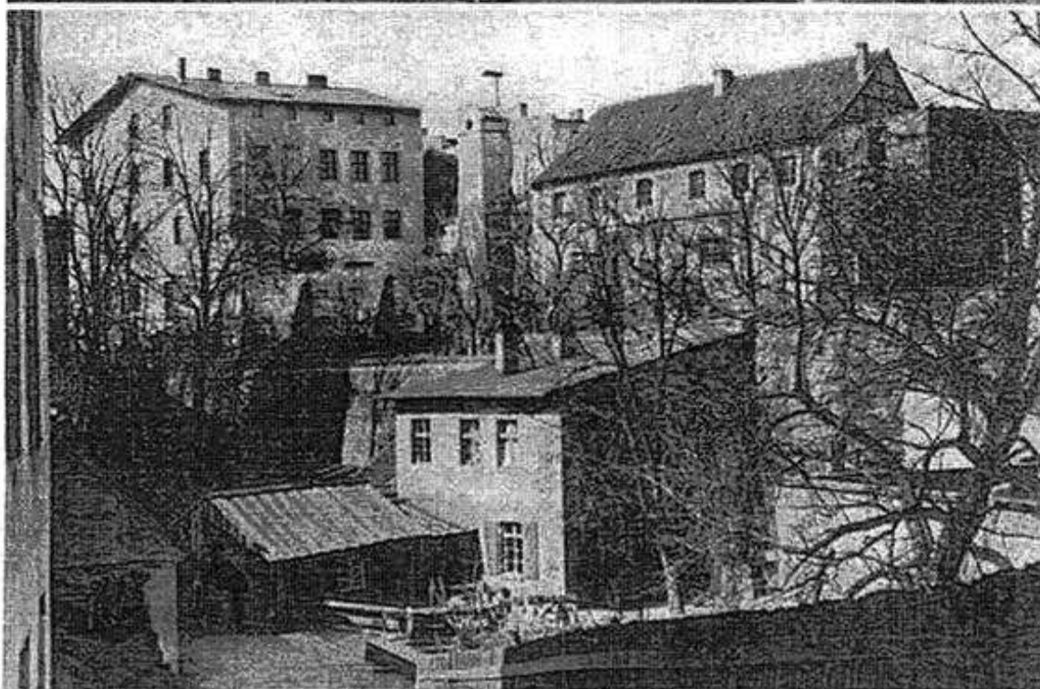
Zabudowa między ulicami Klasztorną i Małogroblową. W tle budynek obecnej przychodni lekarskiej, z prawej – wieżyczka wodociągowa. Na pierwszym planie budynki urządzenia wodociągowego. Kanał Trynka niewidoczny
