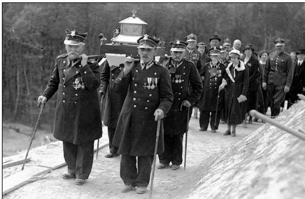
Budowa Kopca imienia marszałka Józefa Piłsudskiego na Sowińcu w Krakowie (maj 1936 r.). Weterani powstania 1863 roku na Sowińcu, (Narodowe Archiwum Cyfrowe).
