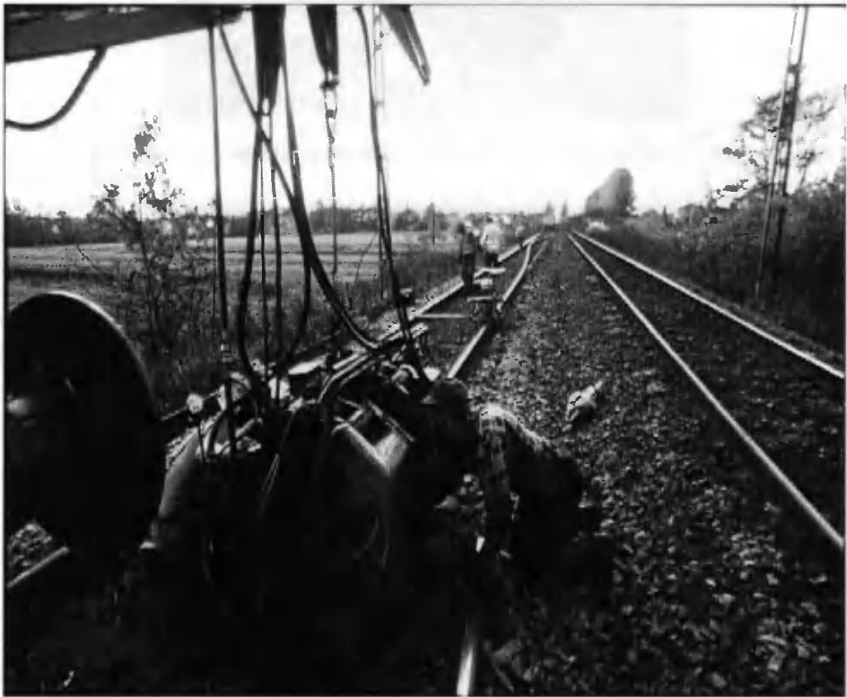
Rys. 14. Ustawianie głowicy typu K 900 zgrzewarki przejazdnej typu PRSM [6]
