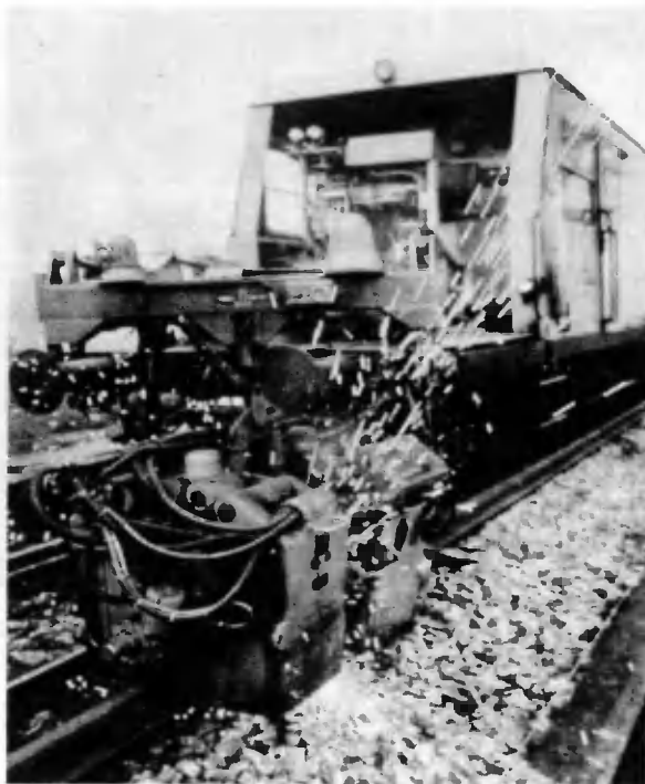
Rys. 15. Zgrzewanie głowicą typu K 900 zgrzewarki przejazdnej typu PRSM [6]
