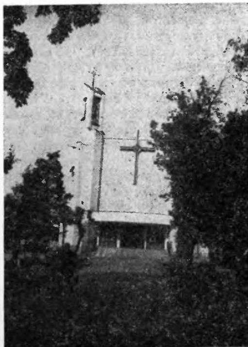
6. Kościół parafialny p.w. św. Krzyża na cmentarzu Nowofarnym przy ul. Artyleryjskiej 10, budowany po 1982 r., z wieżą boczną w części górnej zwężoną jednostronnie, od nazwy jakby oddalającej się, fot. B. Rogalski.
