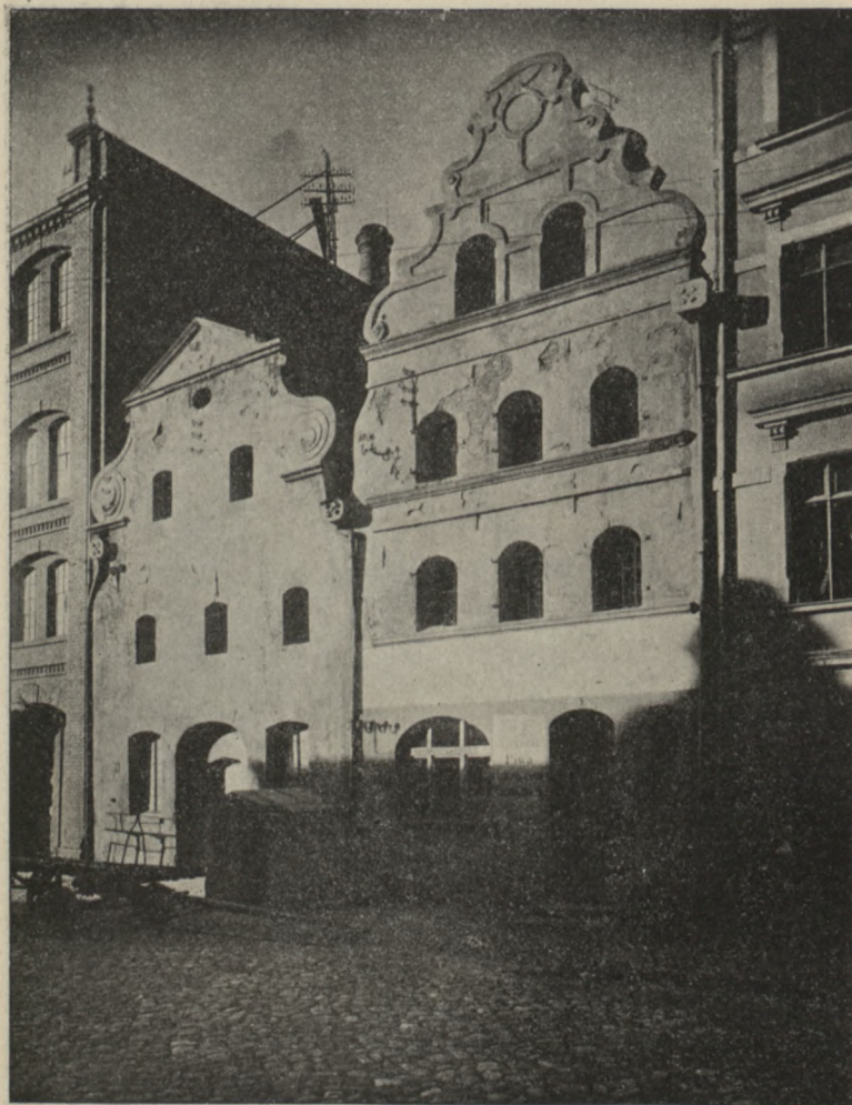
Spichlerz przy ulicy Mostowej.
