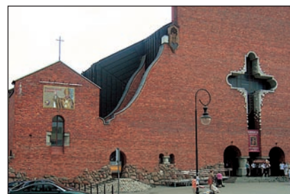
Ryc. 8. Warszawa Ursynów, kościół pw. Wniebowstąpienia Pańskiego (1984-1989, proj. M. Budzyński)
