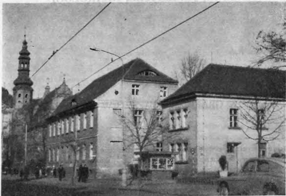
Zakłady Graficzne PZWS od strony ulicy Jagiellońskiej. Na lewo: budynek z roku 1815. Fot. Henryk Piaskowski
