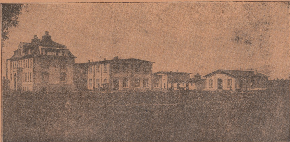
Widok na zabudowania Zakładów.
