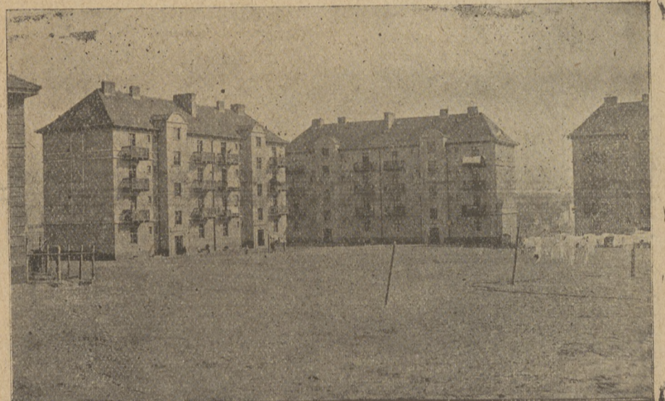
Nowe budowle przy ul. Biskupiej.
