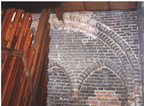
Zdj. 4. Ślepe tryforium na ścianie południowej westwerku w łuku tęczyowym, dwuuskokowym. Fot. M. Szajerka.
