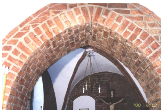
Zdj. 10. Fragment sklepienia zakrystii z gurtem jarzmowym. Fot. M. Kucharski.
