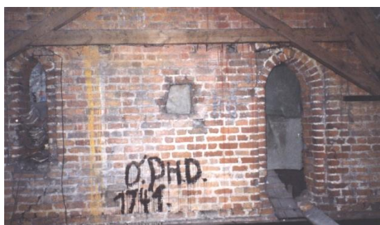
Zdj. 7. Okno i drzwi empory nawowej oraz gniazdo więźby dachowej.
