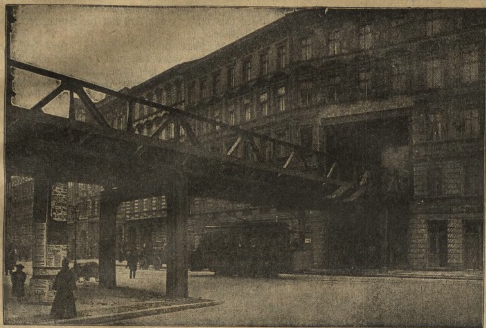
Durchstich eines Hauses an der Bülowstraße für die Berliner Hochbahn.
