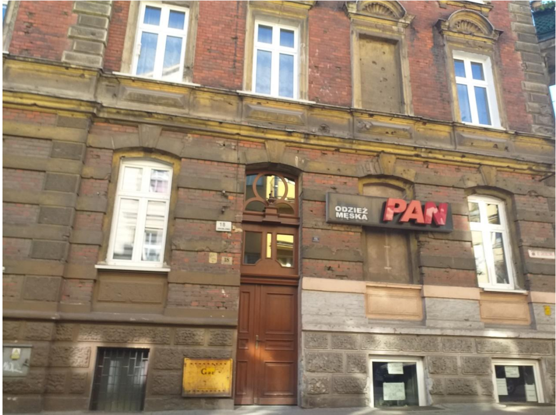
Ulica Groblowa ta kamienica była świadkiem ciężkich walk toczonych w lutym 1945 roku, widać ślady po kulach.
