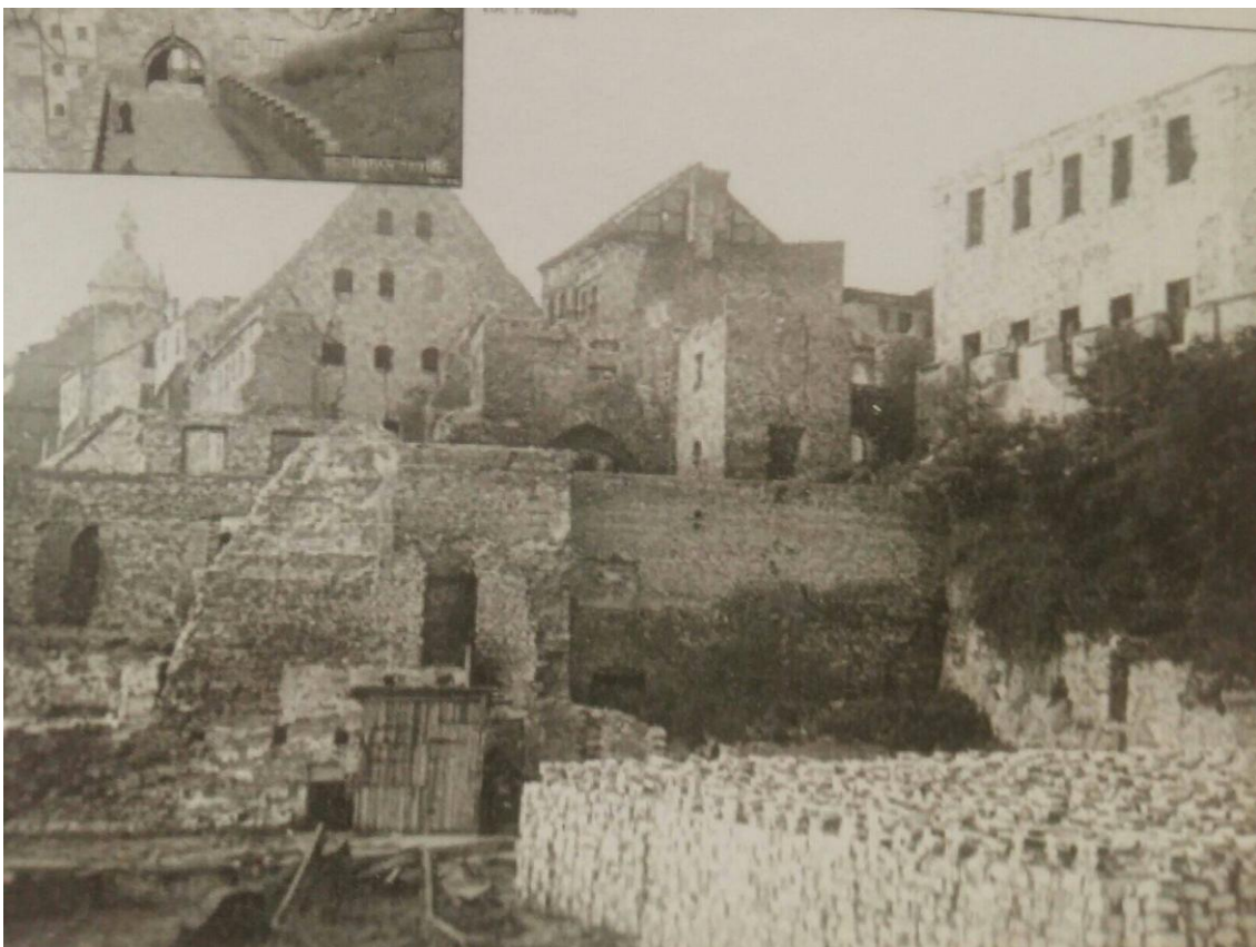
Czas już po wojnie widać ile budynków straciliśmy w okolicy bramy wodnej. Cegła z rozbiórki była wywożona na odbudowę Warszawy.
