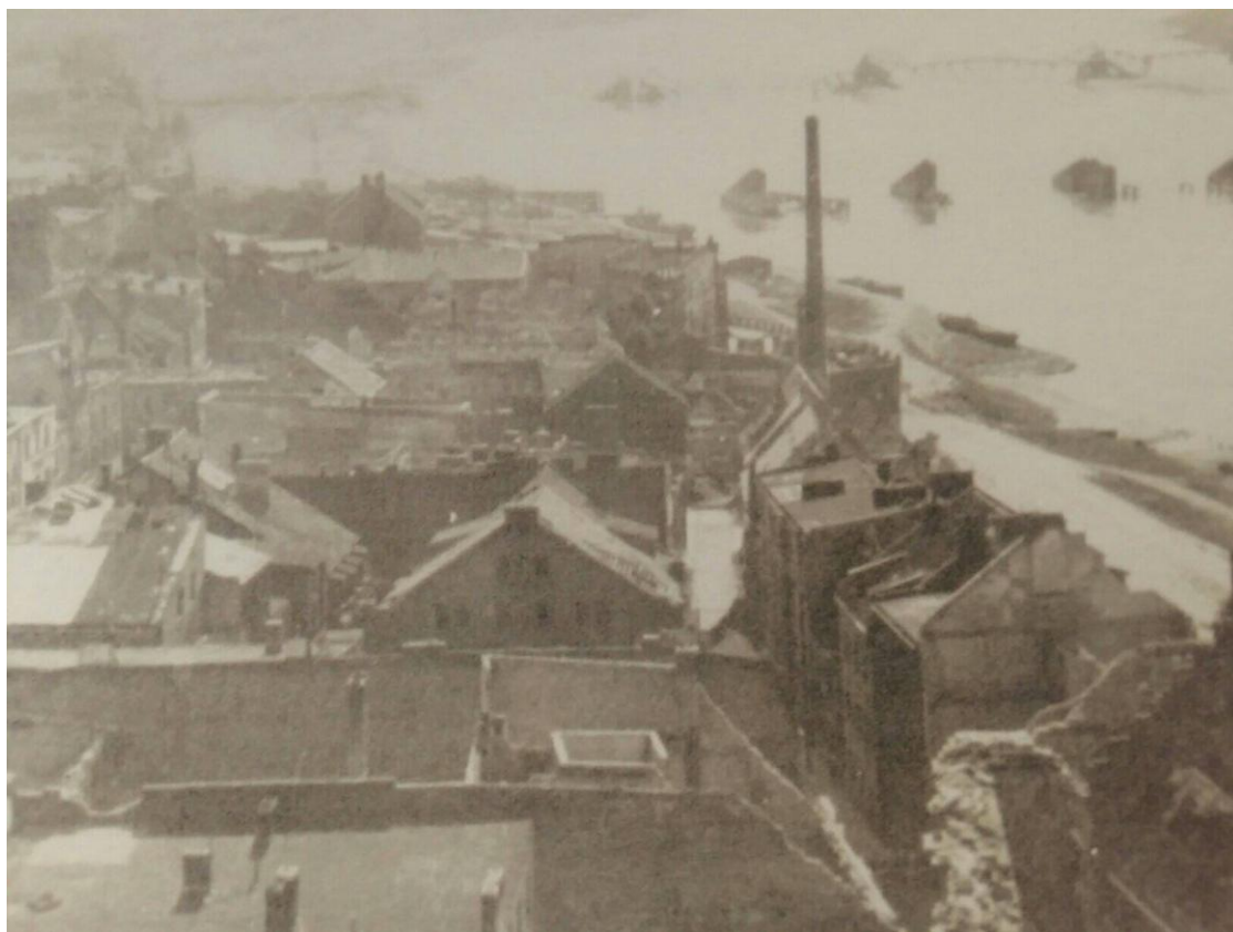
Na tym zdjęciu widać ogrom zniszczeń, spichrza bez dachów.
