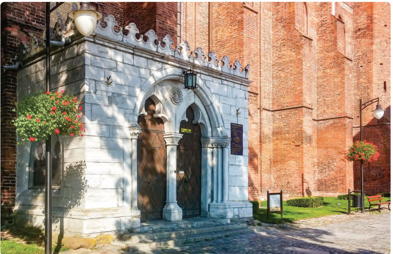
Fot. 6 Kwidzyn, kruchta przy południowej ścianie katedry – fot. P. Grochowski
