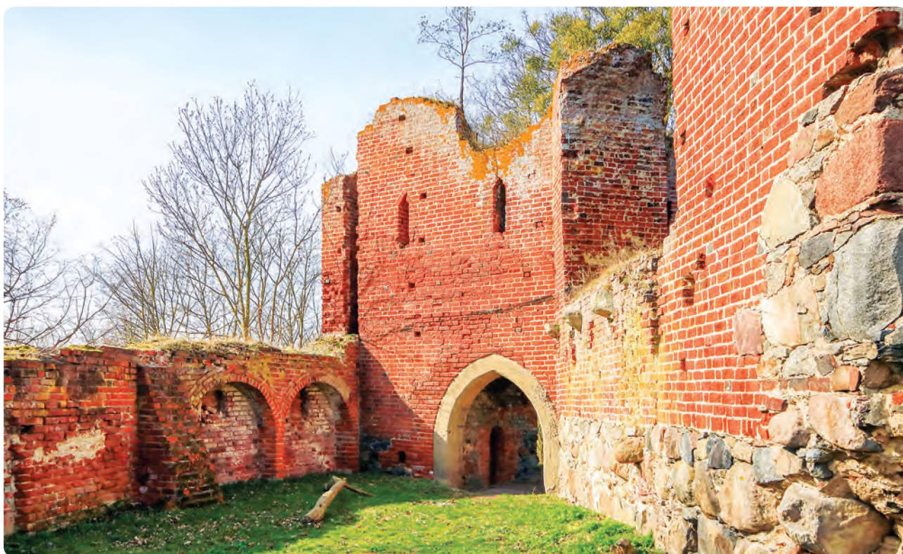
Fot. 26A Pokrzywno, zamek; wieża bramna zamku wysokiego – fot. P. Bilski
