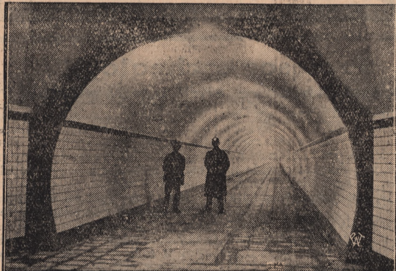
TUNELE POD SKALDA.
