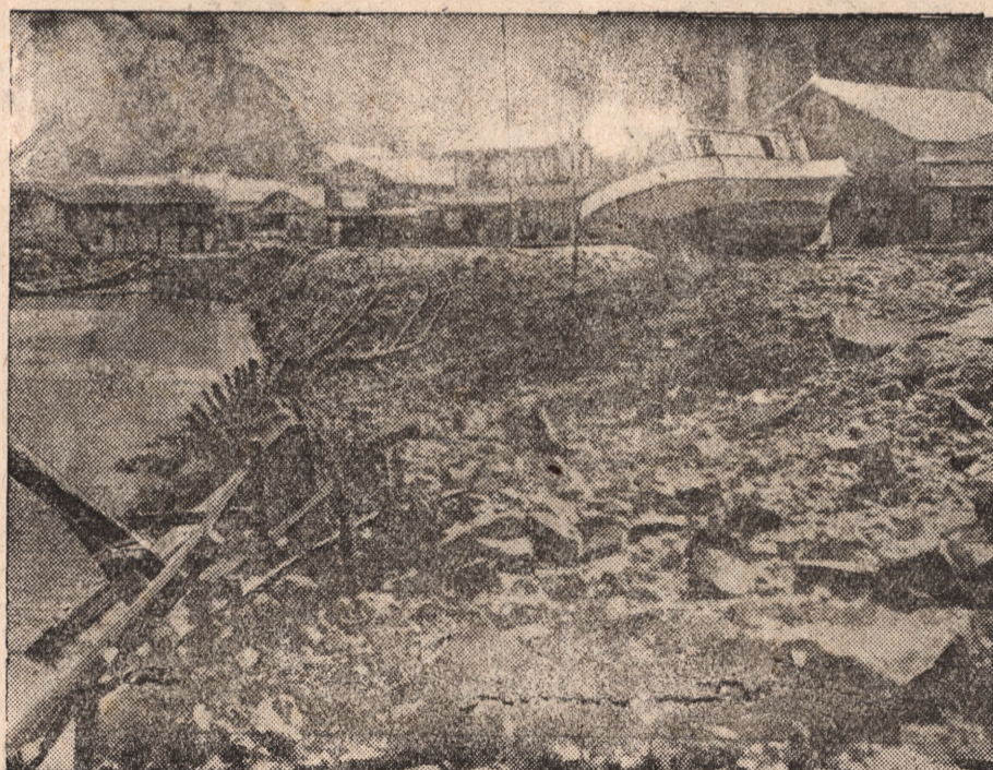
Wielkie spustoszenie spowodowała olbrzymia fala morska na północno-wschodnim wybrzeżu Japonji, wdzierając się na 300 mil szerokiej przestrzeni daleko w głąb kraju. Zniszczeniu względnie uszkodzeniu uległo tysiące domów, tory kolejowe zostały pozrywane z nasypów, a mnóstwo statków woda osadziła na lądzie, jak to widać na zdjęciu.
