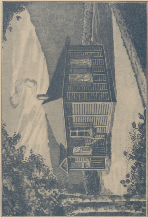
Dreizimmerwohnhaus in Leichtbauweise. Bebaute Grundfläche 37,64 Quadratmeter; Gewicht etwa 6500 Kilogramm.
