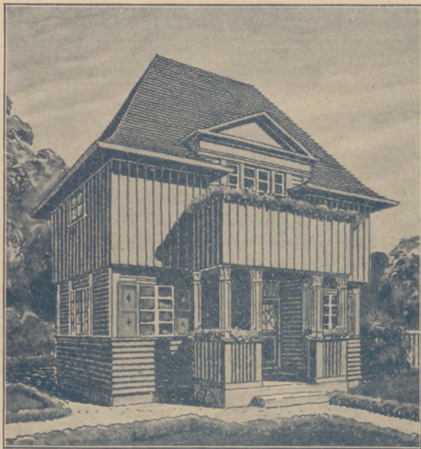
Das sogenannte „Kleinsthaus“. Bebaute Fläche 35,63 Quadratmeter, ungefähres Gewicht 1300 Kilogramm.
