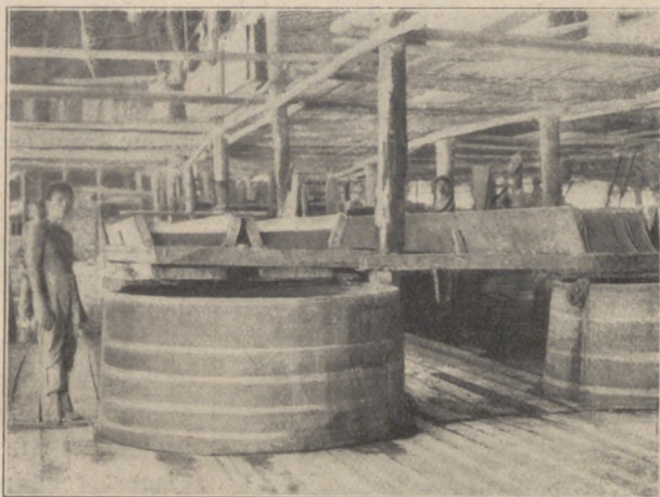
Blick in das Innere der primitiven Kläranlage einer Sago- reinigungsanstalt in Westborneo.
