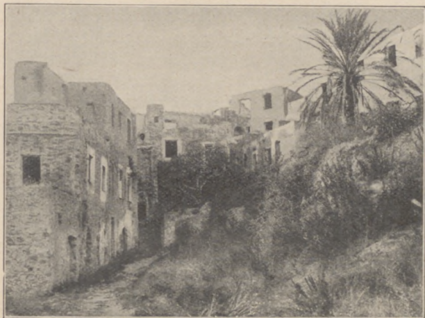
Ruinen von Häusern im zerstörten Bussana.
