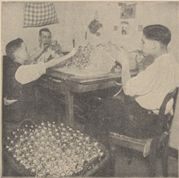
Glaszkugeln werden aus Glasstäben über der Flamme geblasen.
