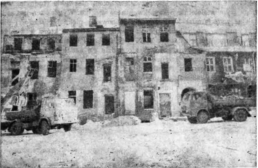
Rewaloryzowana część ul. Jezuickiej od strony ul. Przyrzecze.
