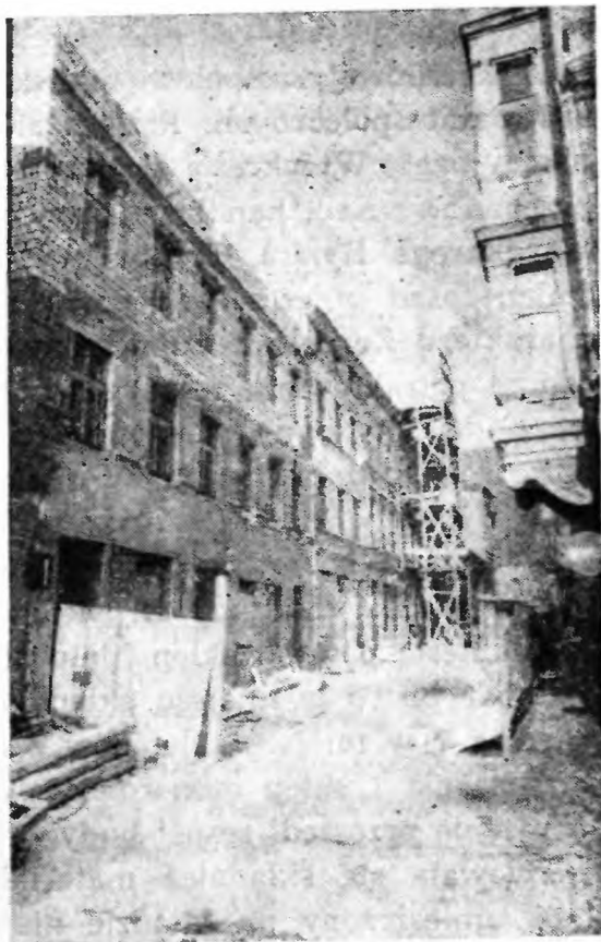
Stare Miasto — prace rewaloryzacyjne domów przy ul. Jezuickiej.
