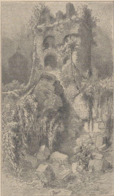
Der gesprengte Turm.
