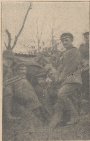
Abb. 4. Fernsprechunterstand in vorderster Linie, durch Überdecken eines Granatloches entstanden.
