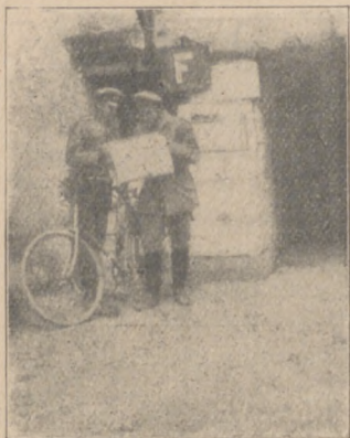
Abb. 3. Fernsprechstation 200 Meter hinter der eigenen Schützenlinie in einer Felsenhöhle.
