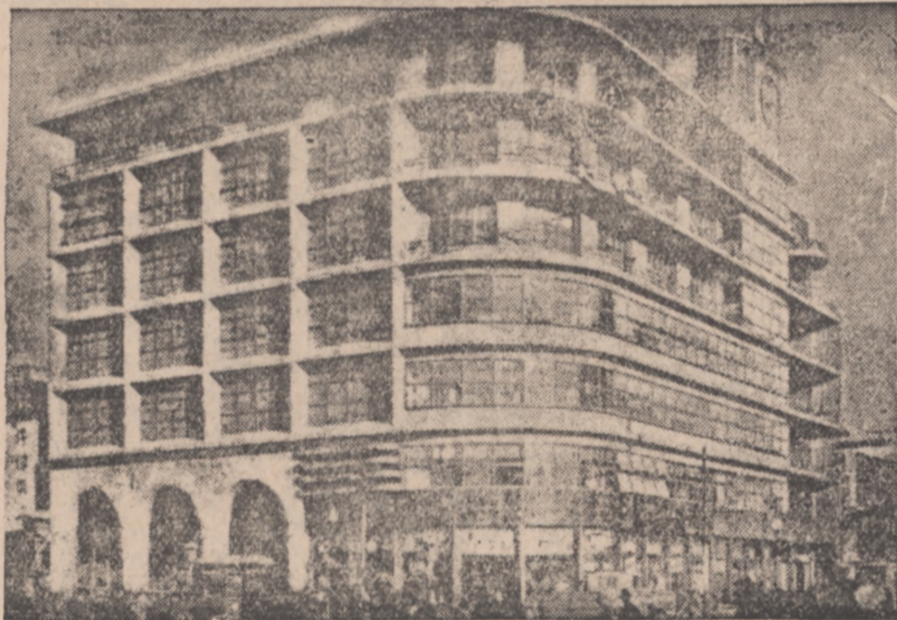
Fronton domu towarowego, który padł pastwą pożaru.
