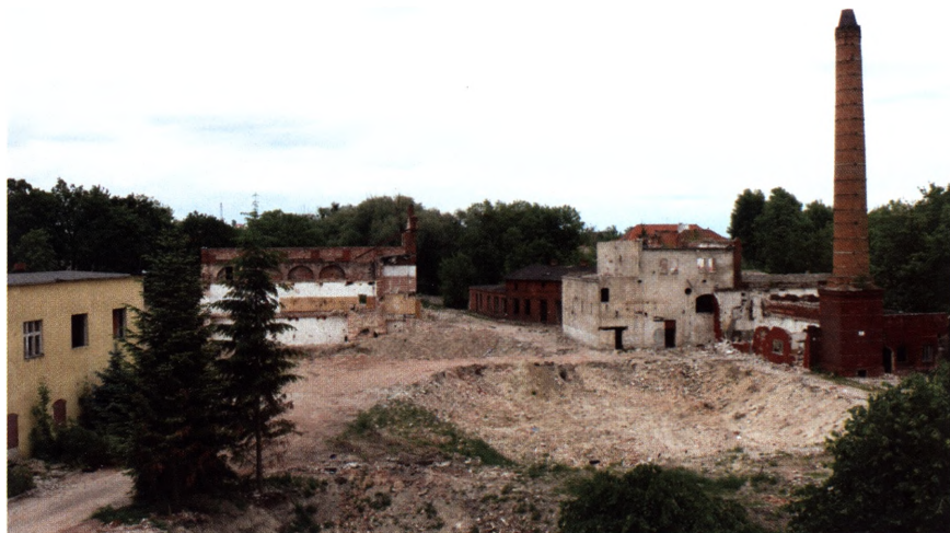
Tak wyglądał browar wkrótce po częściowej rozbiórce
