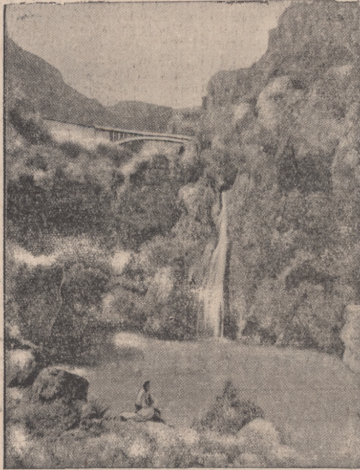
TAK WYGLĄDA MIEJSCE KATASTROFY. Wiadukt kolejowy nad przepaścią koło Tlemcen.
