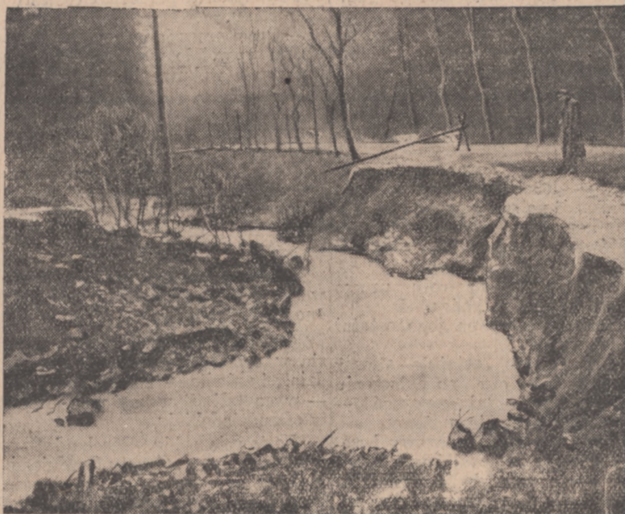
Gdzie była szosa, tam szumi obecnie potok. Zniszczona przez wodę szosa w górach Harcu.
