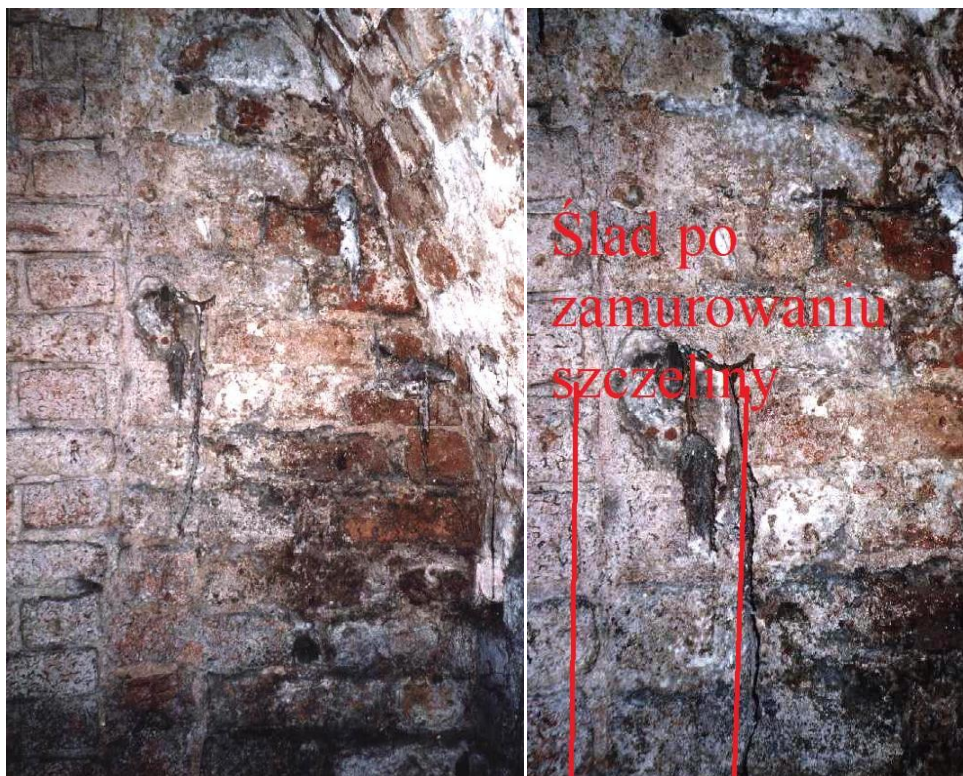
Zamurowana na grubość cegły szczelina strzelnicza z hakiem od kłapy osłonowej.
