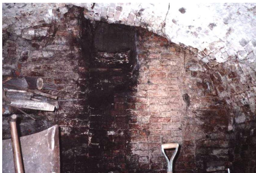
Pierwotnie fragment korony muru obronnego z krenelacją.
