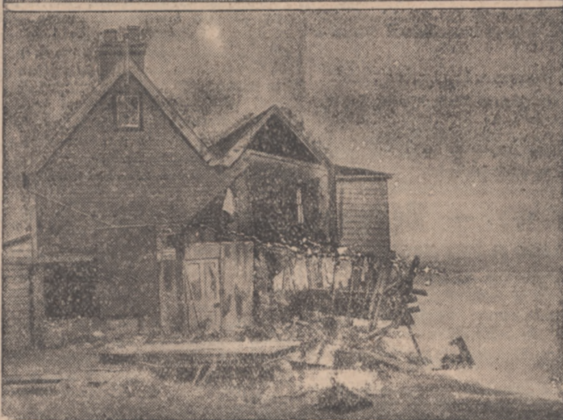
Straszliwy orkan wyrządził w tych dniach wielkie szkody na południowym wybrzeżu angielskim. Zdjęcie górne: przerwanie tamy, dolne: zniszczony dom koło Winchelsea (Południowa Anglja).
