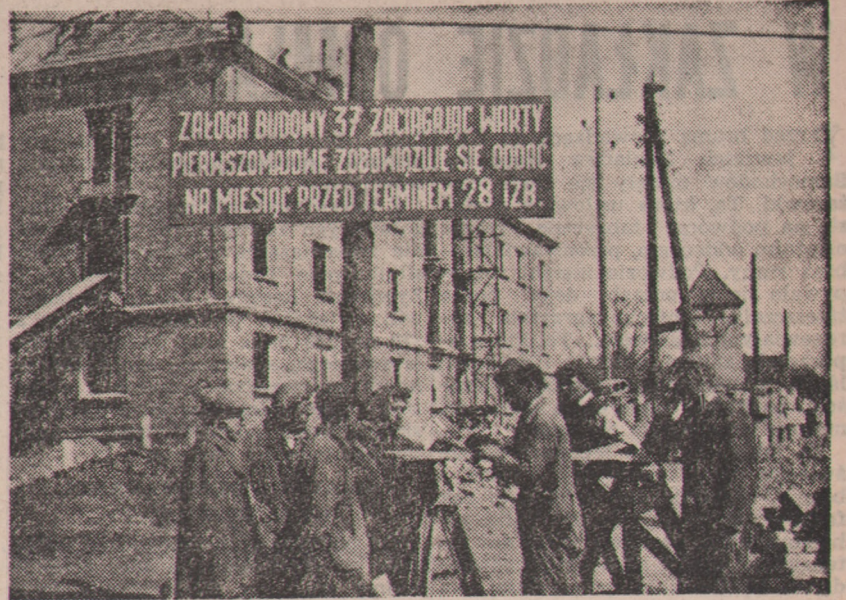
Robotnicy Zjednoczenia Budownictwa Gdańskiego budujący bloki 22 i 20 na budowie nr 37 zaciągnęli warty 1-Majowe, zobowiązując się oddać do użytku na 30 dni przed terminem 28 izb mieszkalnych. Na zdjęciu: Robotnicy zatrudnieni przy budowie bloków 20 i 22 podpisują zobowiązanie 1-Majowe. W głębi blok. CAF — fot. Ukłejewski
