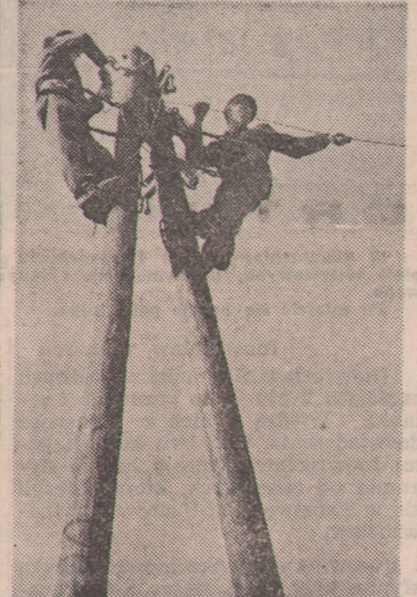
Ekipa Gdańskiego Przedsiębiorstwa Elektryfikacji Rolnictwa pracuje przy elektryfikacji spółdzielni produkcyjnej w Przedbojowicach.
