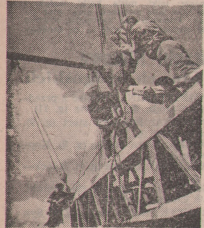
Prace przy budowie metra warszawskiego postępują w prawdziwie warszawskim tempie naprzód.
