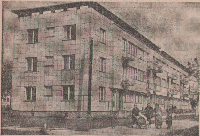
Warszawa. Fragment osiedla mieszkaniowego na Kole.
