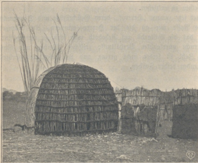
Pontok im Bau.
