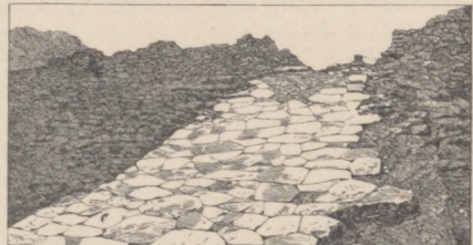
Abb. 7 · Troja II · Rampe des Südwesttores (FM)
