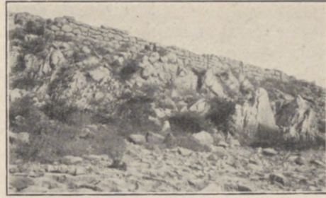
Abb. 65 · Ringmauer der Stadt im Kopaissee
