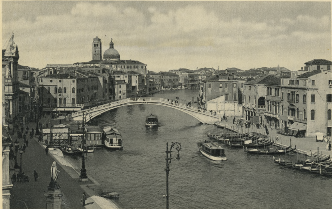
VENEZIA - Nuovo Ponte della Stazione.
