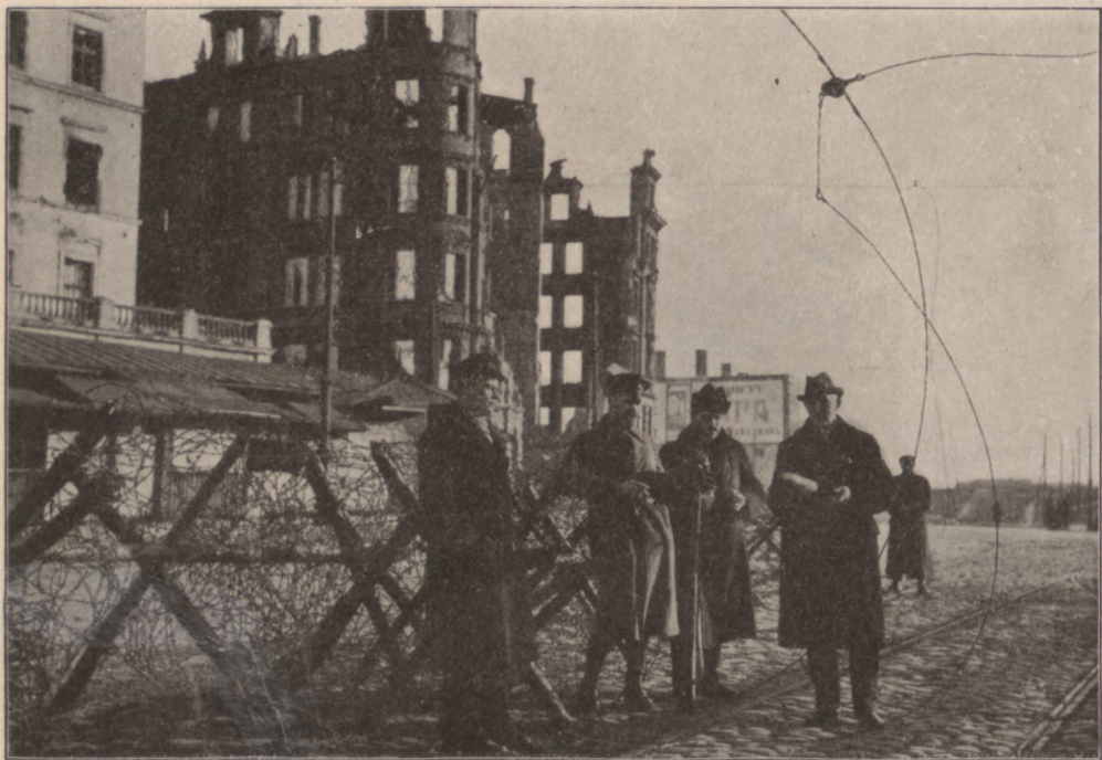
Drahschu aisschogojumi Daugawmalâ. Barrière de fil de fer barbéle sur la rive de la Duna. Barbed wire fences on the Dvina Embankment.
