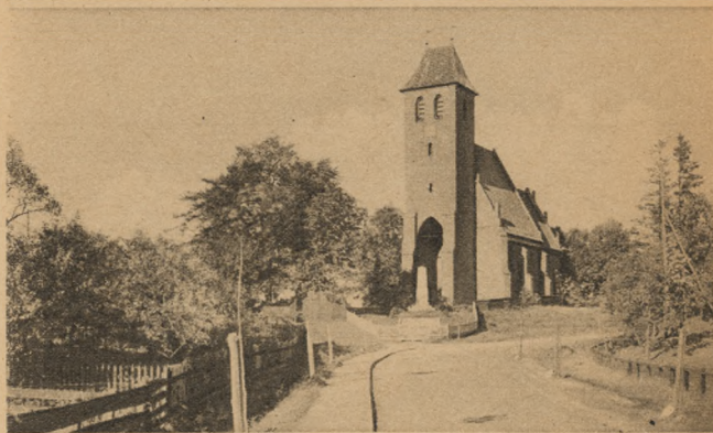
Vorlaubenhaus in Lenzen und Dorfkirche in Dörbeck Vorlaubenhaus in Lenzen and village church in Dörbeck Maison à porche à Lenzen et l'église du village de Dörbeck
