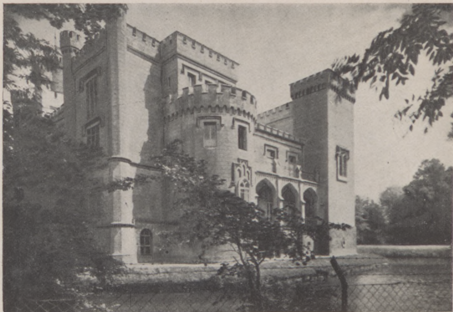
6. Kórnik — Zamek od strony zachodniej
