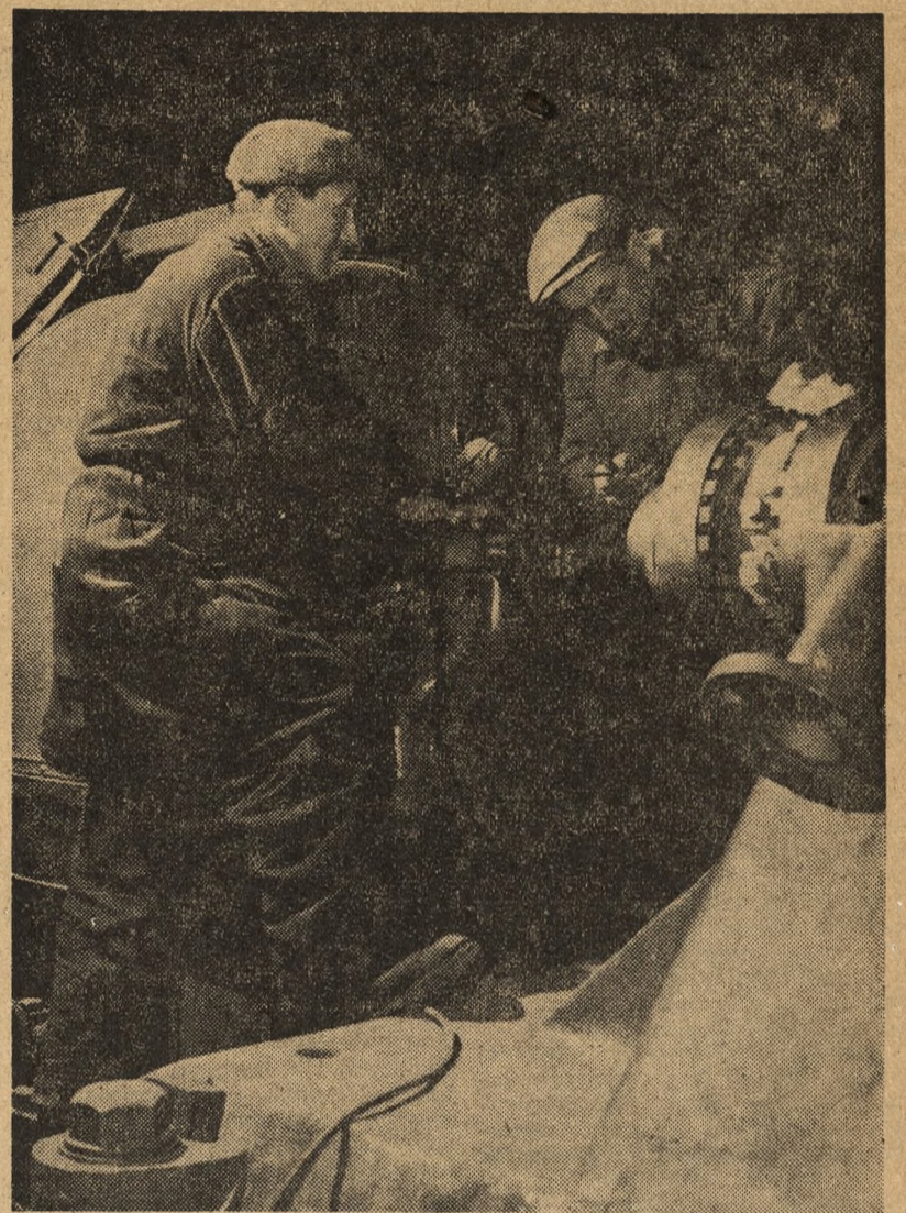
Na zdjęciu: Brygadzista EDWARD KOLKA i JÓZEF BANASIK centrują — kolektor turbiny. Ich brygada przy montażu turbiny wyrobienia 290 proc. normy. Foto: CAF — Tyński
