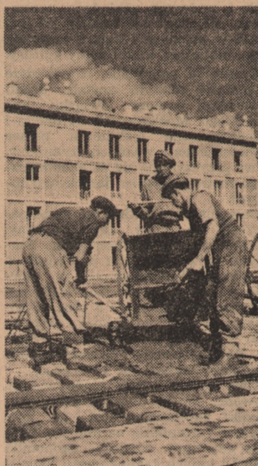
Grupa betoniarzy Stanisława Kowalczyka pracuje przy nowym bloku. (Foto — CAF)
