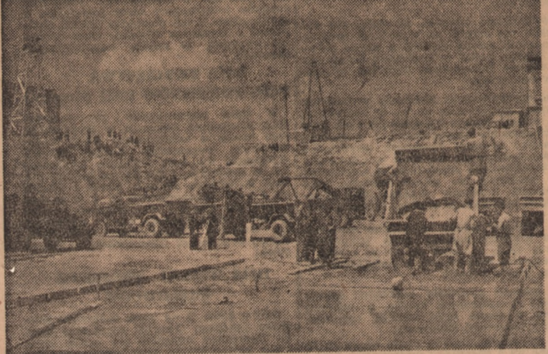
Na budowie panuje ożywiony ruch.
