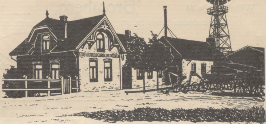
Windelektrizitätswerk der Gemeinde Kronsmoor bei Itzehoe.
