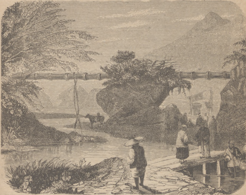
Eine Wasserleitung in China aus Bambusrohr.
