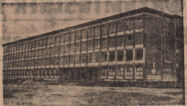
Politechnika Śląska wzbogaciła się o kilka nowych gmachów. Jednym z nich jest gmach Inżynierii Budowlanej o kubaturze 70 tysięcy metrów sześciennych. Pomieści on liczne sale wykładowe, pracowni i t.p. Na zdjęciu: Nowy gmach Inżynierii Budowlanej. (Foto — CAF)
