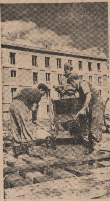
Grupa betoniarzy Stanisława Kowalczyka pracuje przy betonowaniu stropów nowego bloku 3-b przy ul. Pięknej. Grupa podjęła, z okazji zbliżających się wyborów do Sejmu i XIX Zjazdu WKP(b), zobowiązanie zaoszczędzenia 72 roboczo-godzin przy betonowaniu trzeciego stropu na bloku 3-b. (Foto - CAF)
