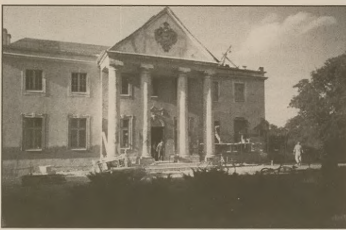
Pałacyk podczas prac remontowych
