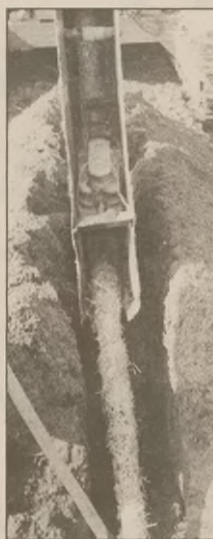
Układanie węża w ziemi
