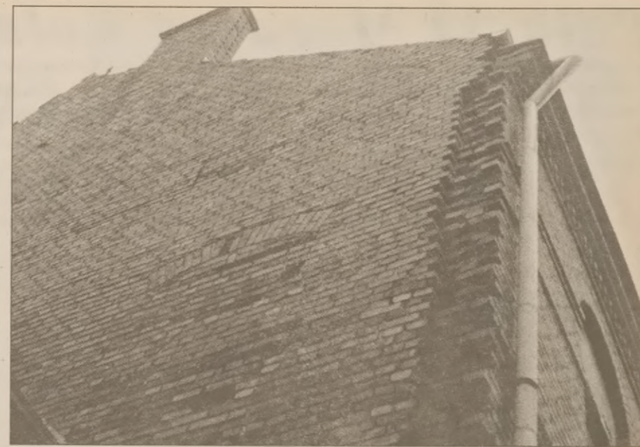
Te pozostawione w celu dowiązania wtku cegły zaświadczać, jaki kształt miała mieć bryła Ratusza.
