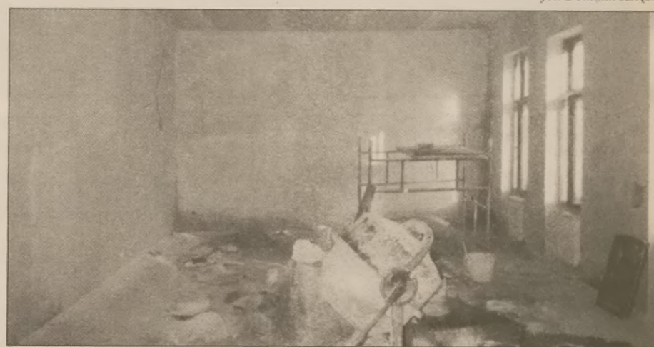
Jeszcze niedawno w przyszłej galerii wystaw czasowych ekspozowana była jedynie betoniarka
