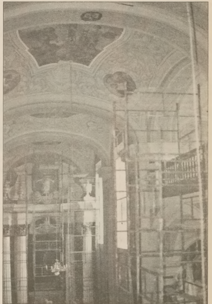
Kościół podczas remontu
