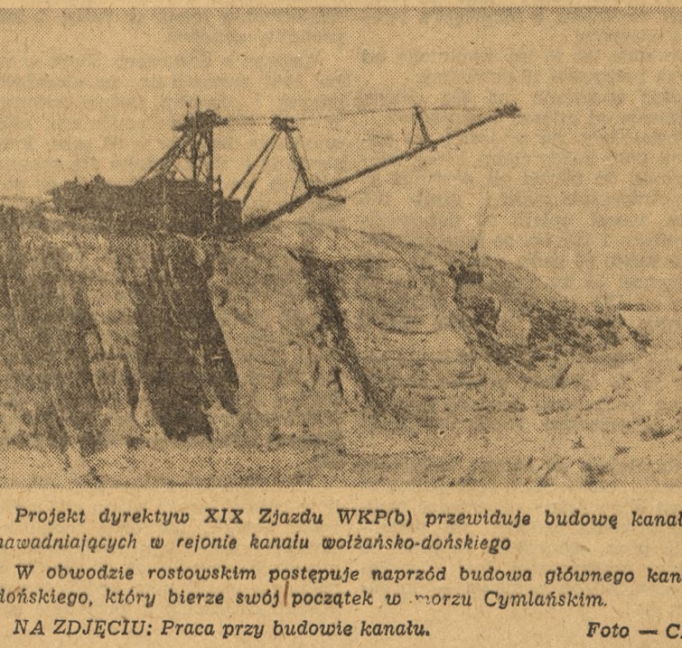
Projekt dyrektywy XIX Zjazdu WKP(b) przewiduje budowę kanałów nawadniających w rejonie kanału wołżańsko-dońskiego. W obwodzie rostowskim postępuje naprzód budowa głównego kanału dońskiego, który bierze swój początek w porzu Cymlańskim. NA ZDJĘCIU: Praca przy budowie kanału. Foto — CAF
