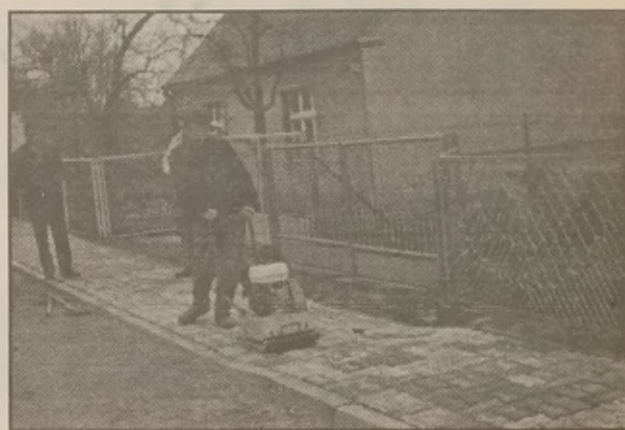
Jacek Szczepankiewicz przy budowie chodnika
