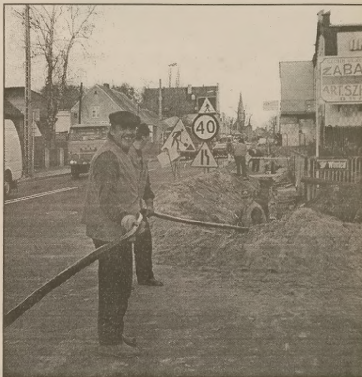
Przy układaniu kabla.
