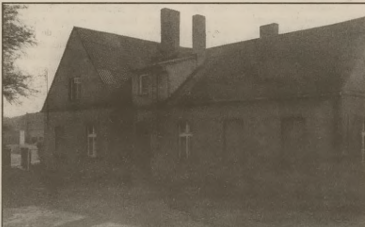
Przed laty mieściła się tu szkoła podstawowa, teraz dom przy placu św. Wojciecha 2 jest budynkiem mieszkalnym. Czy w przyszłości będzie tu muzeum - czas pokaże.
