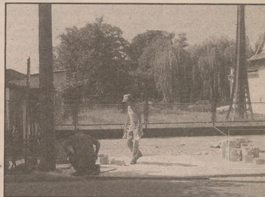
Pracownicy Zakładu Usług Miejskich Józef Falał i Tadeusz Wójtowicz układają kostkę na chodniku przy powstającym parkingu obok Posterunku Policji w Janowcu Wlkp.
